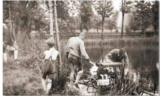
Pumparbeit beim Schmiedeteich – neue Pumpe Type C60, Bj. 1931
